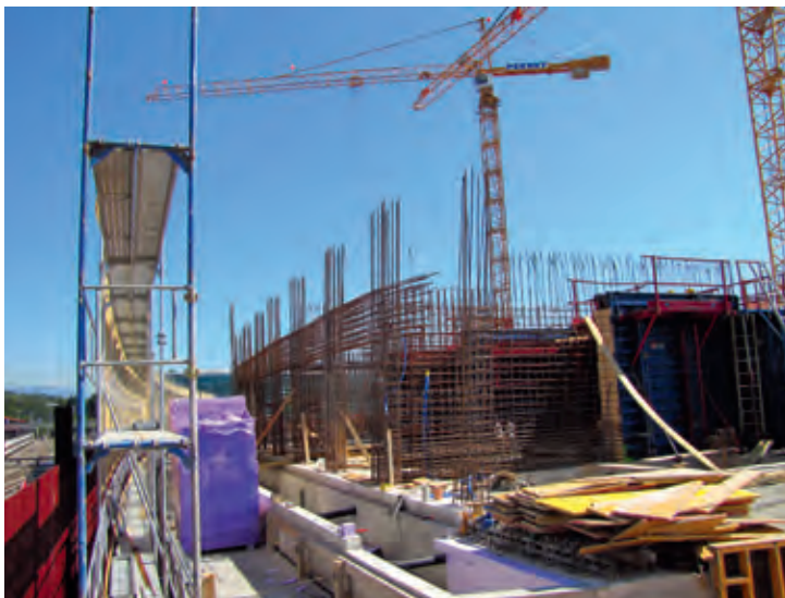
Chantier de la Maison des étudiants. Photo IHEID/Edgardo AMATO.
