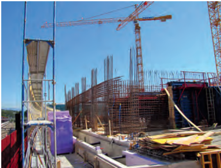
Chantier de la Maison des étudiants. Photo IHEID/Edgaro AMATO.
